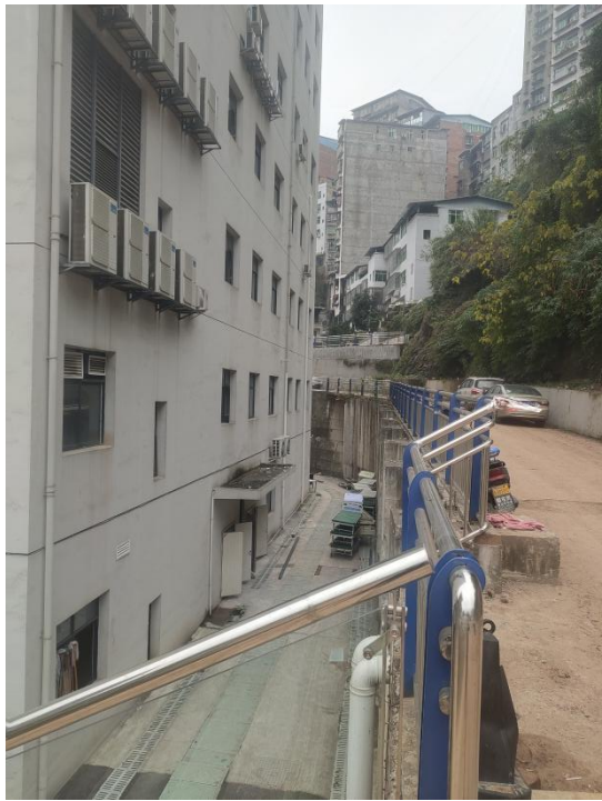
2 号住院综合楼北侧
